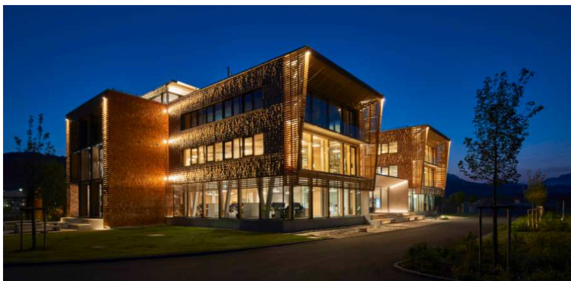
Nuovo edificio BORA nella sede di Niederndorf
