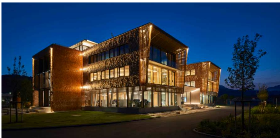
BORA Neubau am Standort Niederndorf
